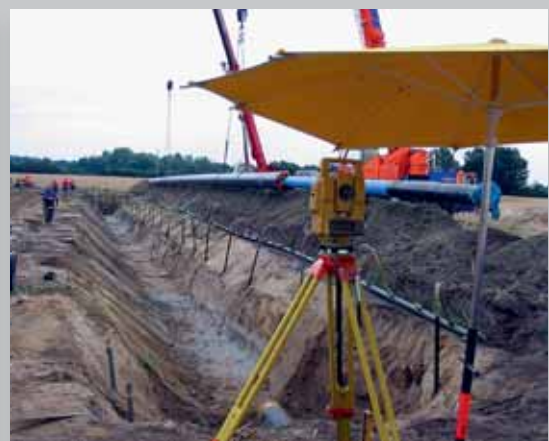
Baubegleitende Vermessung beim Transportleitungsbau
